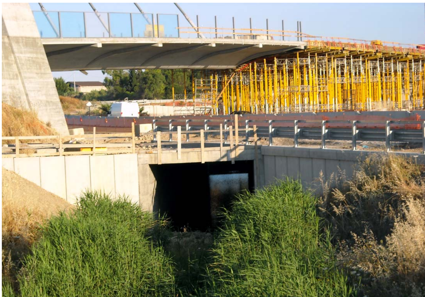
I tre livelli dello svincolo: in alto il piano viabile del nuovo ponte; sotto il piano viabile della SS 554 e sotto ancora, tra la vegetazione, il fornice del sottopasso delle ex Ferrovie Complementari della Sardegna.
