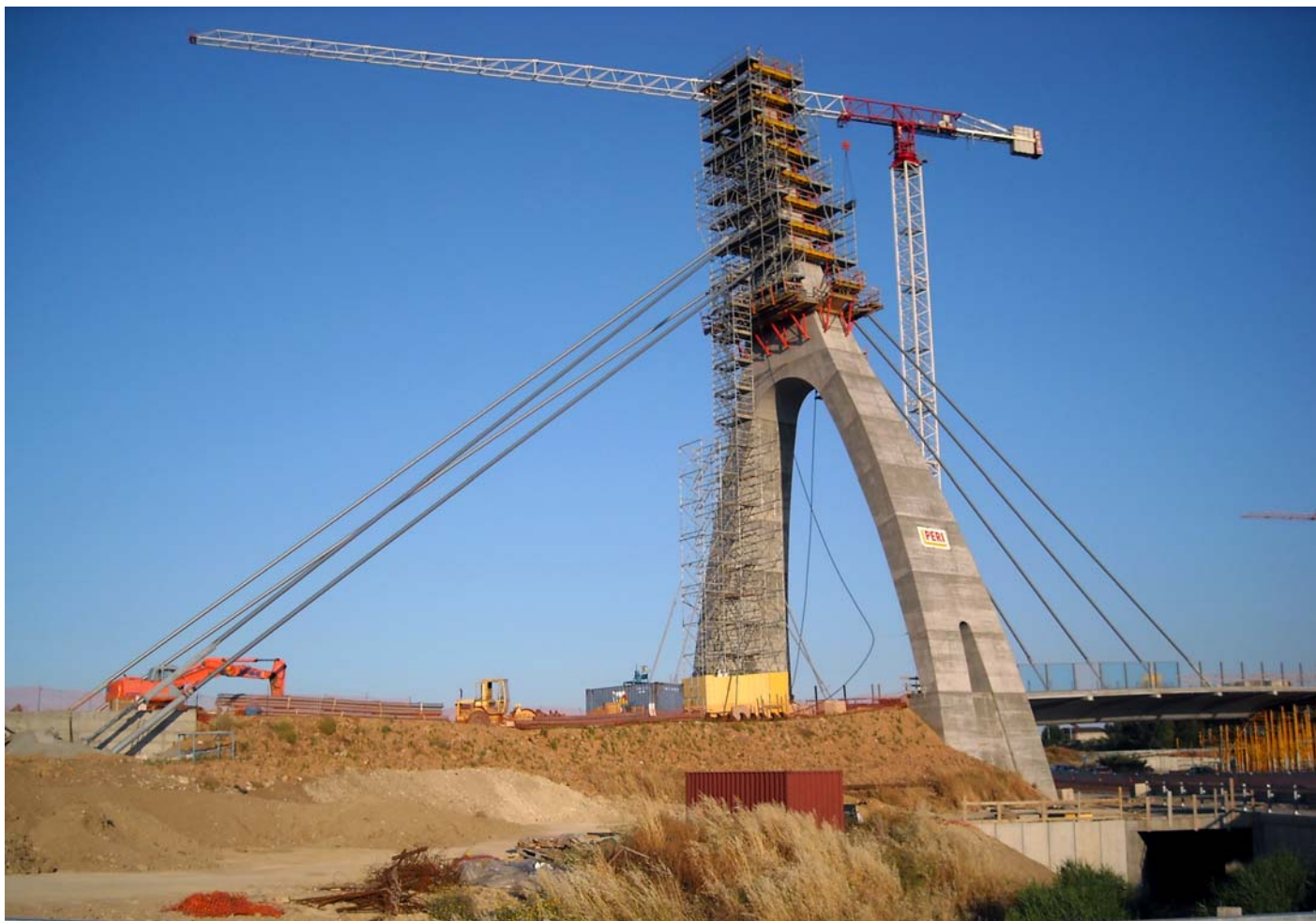
Vista generale (al 26 maggio 2009) del nuovo ponte strallato che scavalcando la strada statale 554 permetterà di raggiungere la Cittadella universitaria e il Policlinico di Monserrato.
